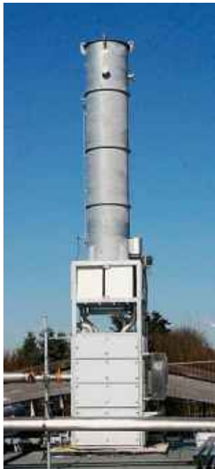
Weithin sichtbar: der Abfackelturm auf dem Dach der Vergärungsanlage. Foto: Cornelia Müller
