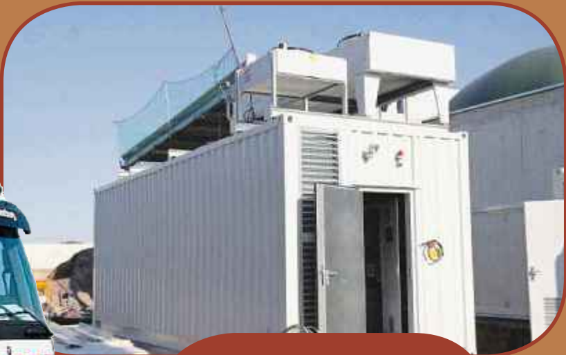
Schritt 3: Das entstandene Bio-Gas wird in ein Blockheizkraftwerk geleitet. Ein achtzylindriger Gasmotor wandelt mit Hilfe eines Generators das Gas in Strom und in Wärme um.
