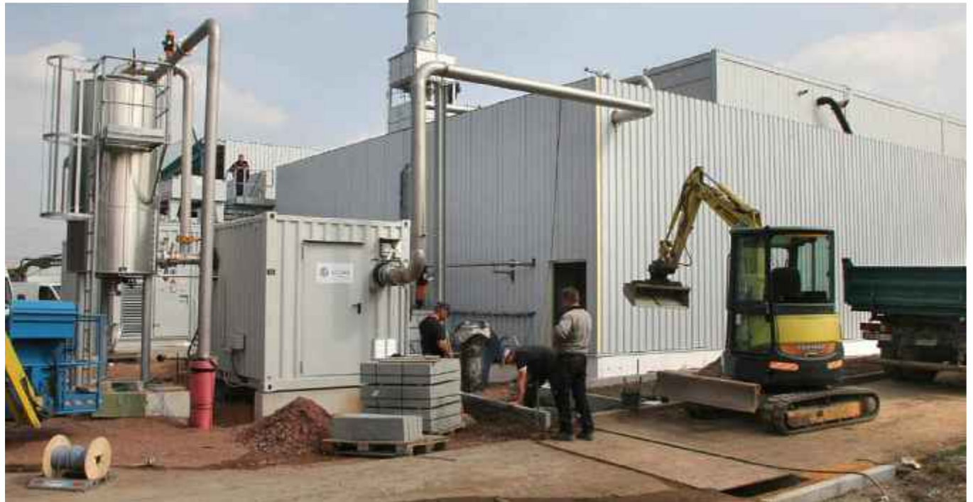
Nach nur neun Monaten Bauzeit geht die Vergärungsanlage am Kompostwerk der GBAB jetzt in Betrieb. Sie ist mit ihrer thermophilen Technik einzigartig in Deutschland. Foto: Peter Rogowsky
